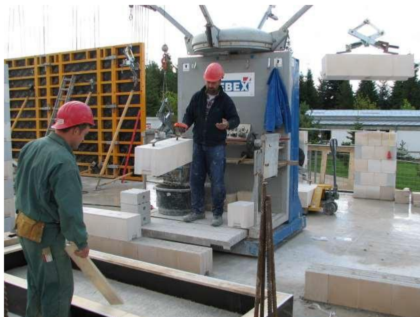
Obr. 2 Jiný typ zdícího stroje pro menší bloky, Norimberk 2008; foto: autor
