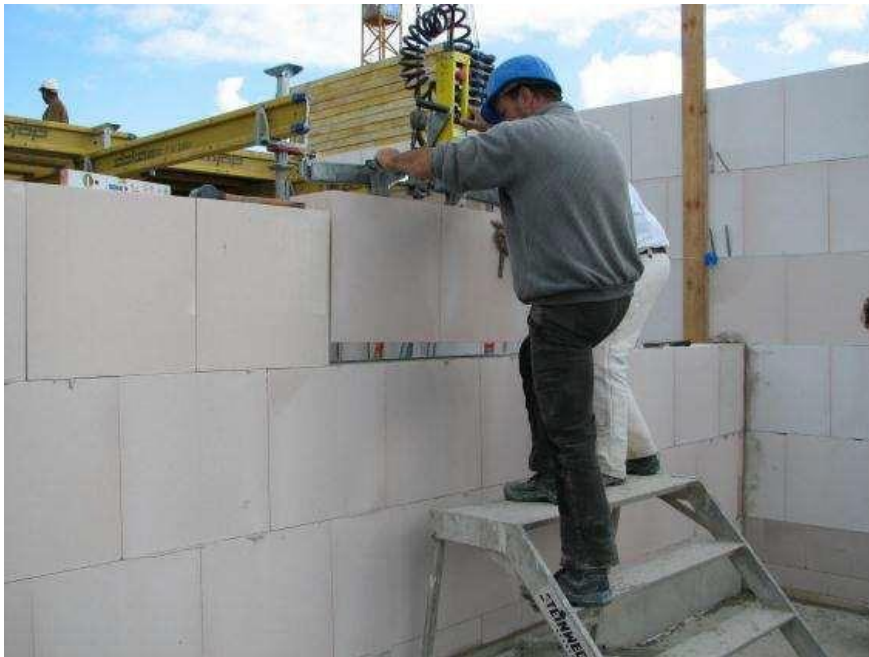
Obr. 6 Strojní zdění KS-QUADRO – usazování 2 bloků (0,5 m 2 ) najednou, foto: autor
