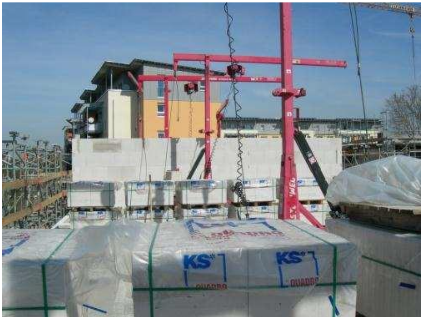
Obr. 7 Strojní zdění KS-QUADRO – nasazení více minijeřábů na větší stavbě najednou; foto: autor
