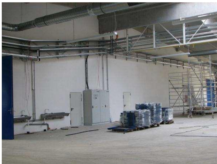
Obr. 3 Zdívo KS-QUADRO Zapf Daigfuss na protipožární zdi v hale v Domažlicích, opatřené pouze bílým nátěrem; foto: autor
