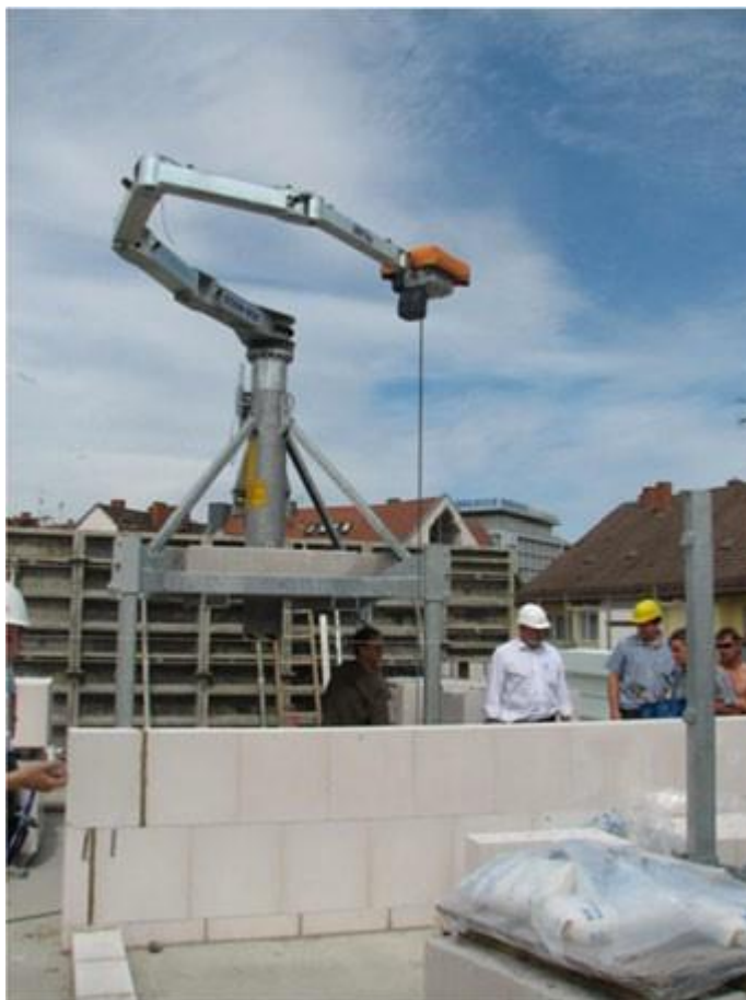
Obr. 1 Strojní zdění je zcela běžnou záležitostí v sousedním Německu již více než 25 let. Na fotografii strojní zdění pomocí univerzálního zdícího stroje Stein-Rex Norimberk 200; foto: autor
