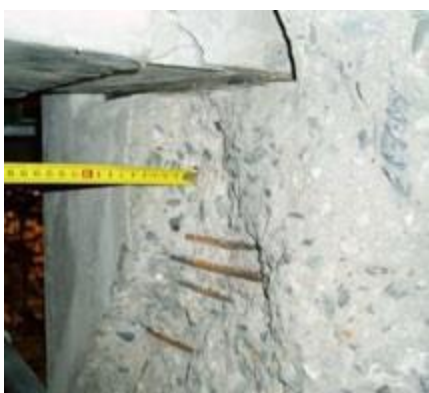
Obr. 15 Chaoticky uplavaná výztuž s obnaženou částí ložiska po odprýsknutí krycí betonové vrstvy sloupu v úložné oblasti
