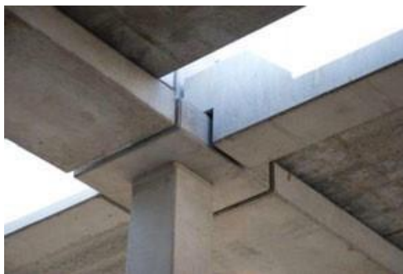
Obr. 5 Detail uložení nosníků střešní konstrukce
