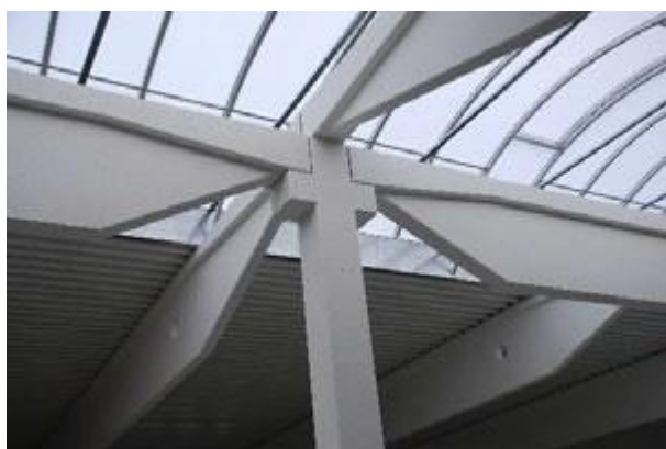
Obr. 19 Detail sníženého uložení
