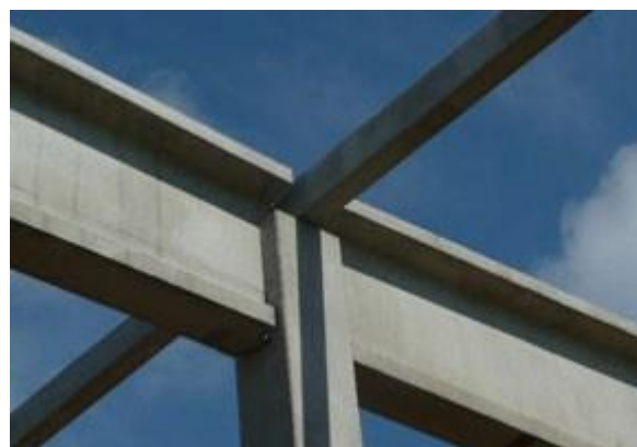
Obr. 20 Detail vidlicového zhlaví
