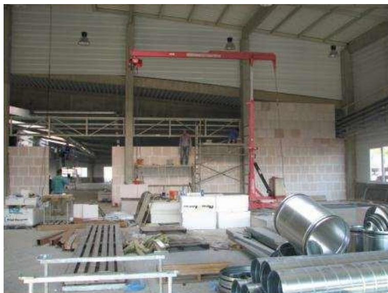
Obr. 4 První strojní zdění KS-QUADRO v ČR pomocí minijeřábu v roce 2007; foto: autor
