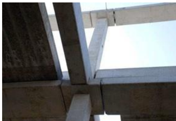
Obr. 6 Detaily uložení nosníků na konzoly průběžného sloupu s odlišně širokými styčnými spárami
