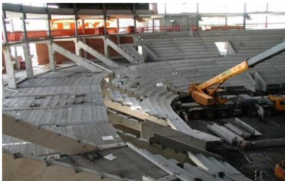
Obr. 11 Montáž prefabrikované tribuny a stropní konstrukce
