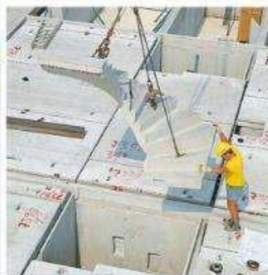
Obr. č. 2 – momentka z pokládky a montáže točitého schodiště
