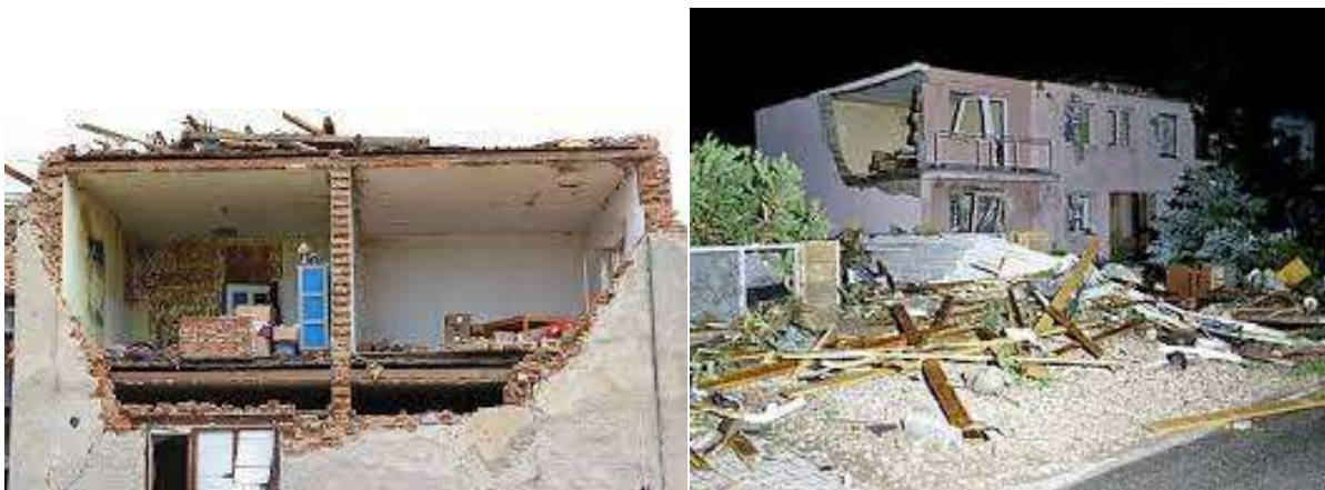
Obr. 4 a 5 Destrukce stěn nezatížených stropy, zdroj: internet Tornádo Morava – Google obrázky
