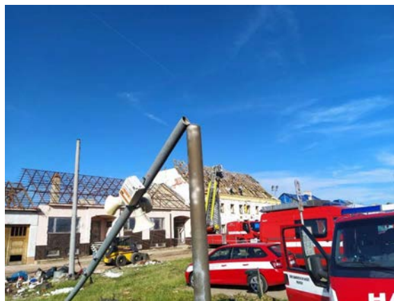
Obr. 2 Zlomený sloup veřejného rozhlasu
