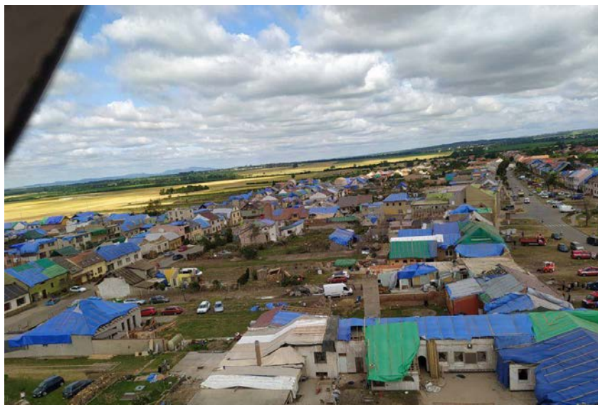
Obr. 6 Část obce Moravská Nová Ves po zasažení tornádem
