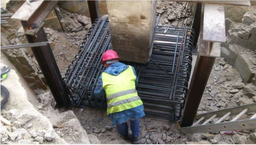
Obr. 3 Armování nového základu pod stojící konstrukcí
