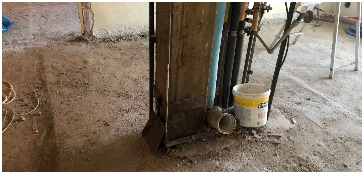
Obr. 1 Odhalený panelový strop s prostupem pro svislé instalační rozvody po odstranění podlahy
