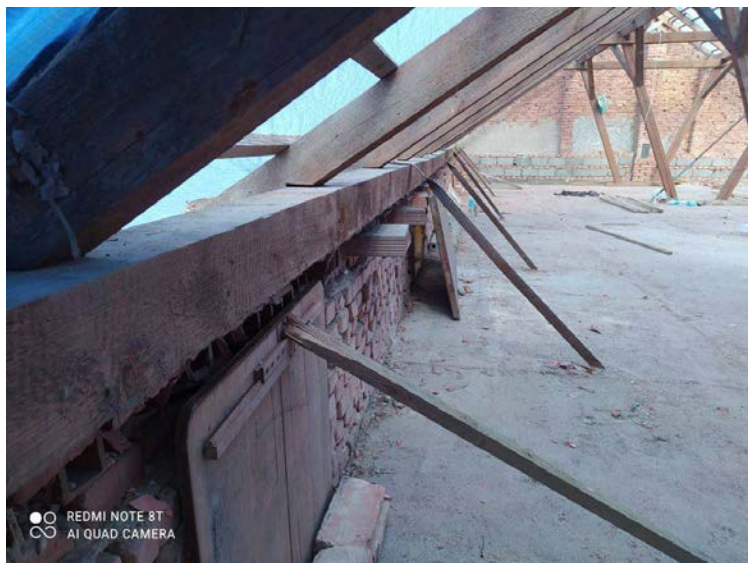
Obr. 11 Posunutí konstrukce krovu v úrovni pozednice.
