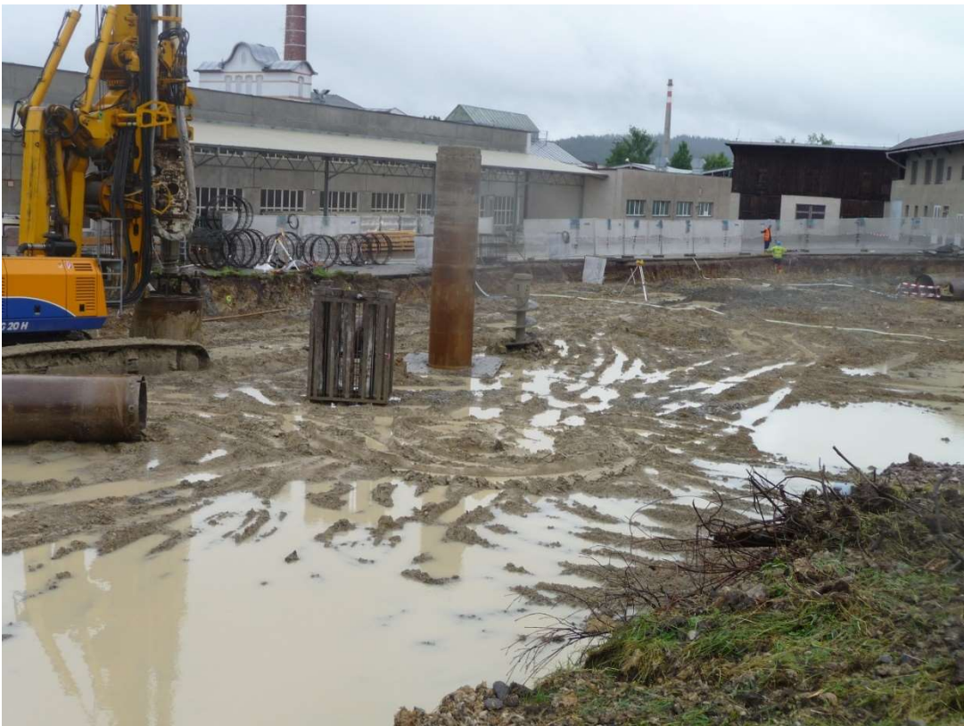
Obr. 2 Situace na staveništi
