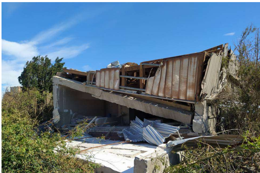
Obr. 1 Budova v areálu zemědělského podniku v Moravské Nové Vsi
