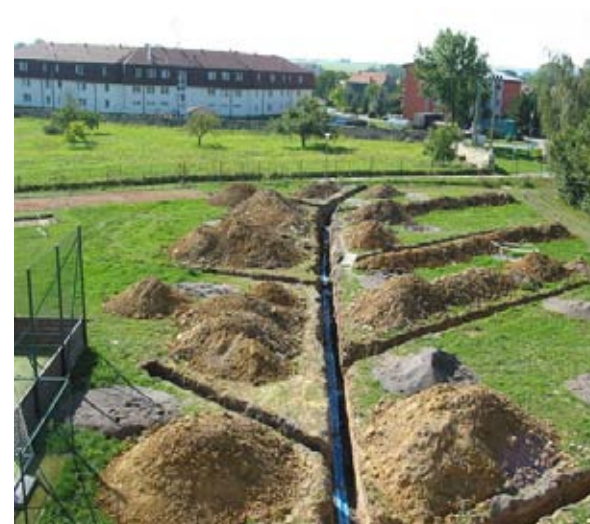
Propojení vrtů horizontálním vedením, kompletace primárního okruhu pod povrchem hřiště základní školy v Dolním Újezdě
