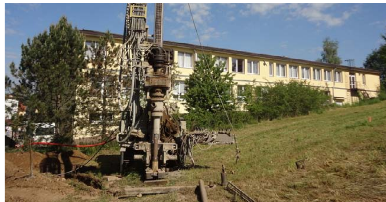
Vrtná souprava pro vyvrtání 120 m hlubokého vrtu
