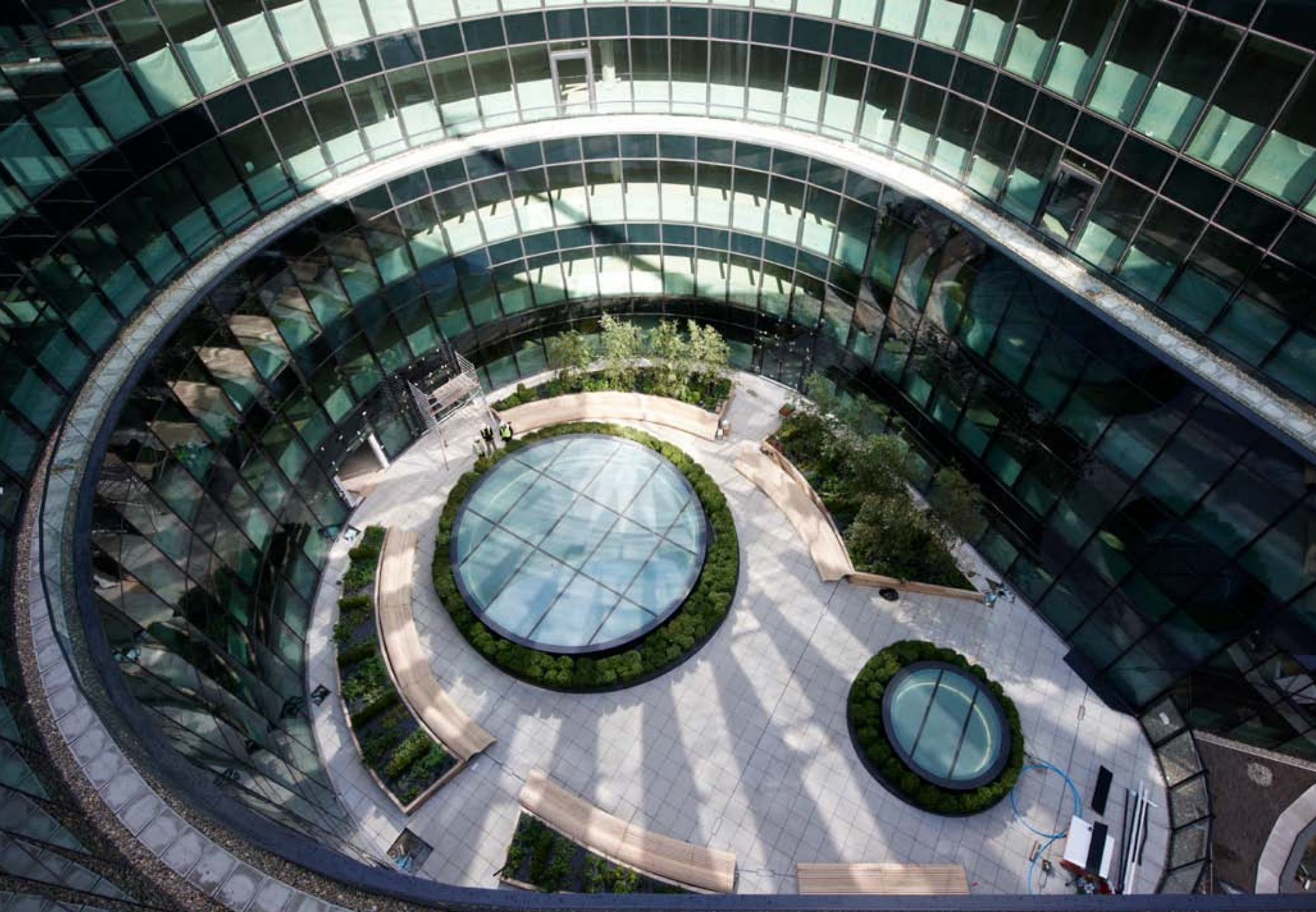
Atrium kancelářských budov Seven more London (foto: Nigel Young, Foster + Partners). více >>
