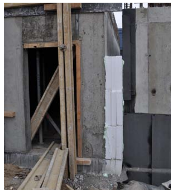
Obr. 9 Vytápěné oddělení vpravo a nevytápěné části budovy s 300 mm tlustou deskou z EPS
