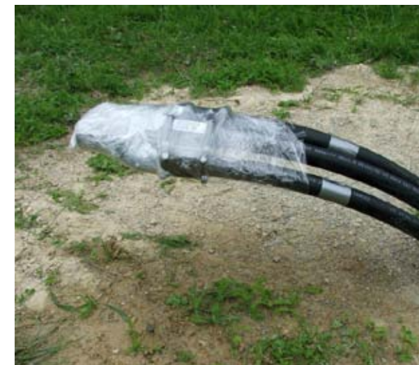
Zapuštěná geotermální sonda připravená k napojení
