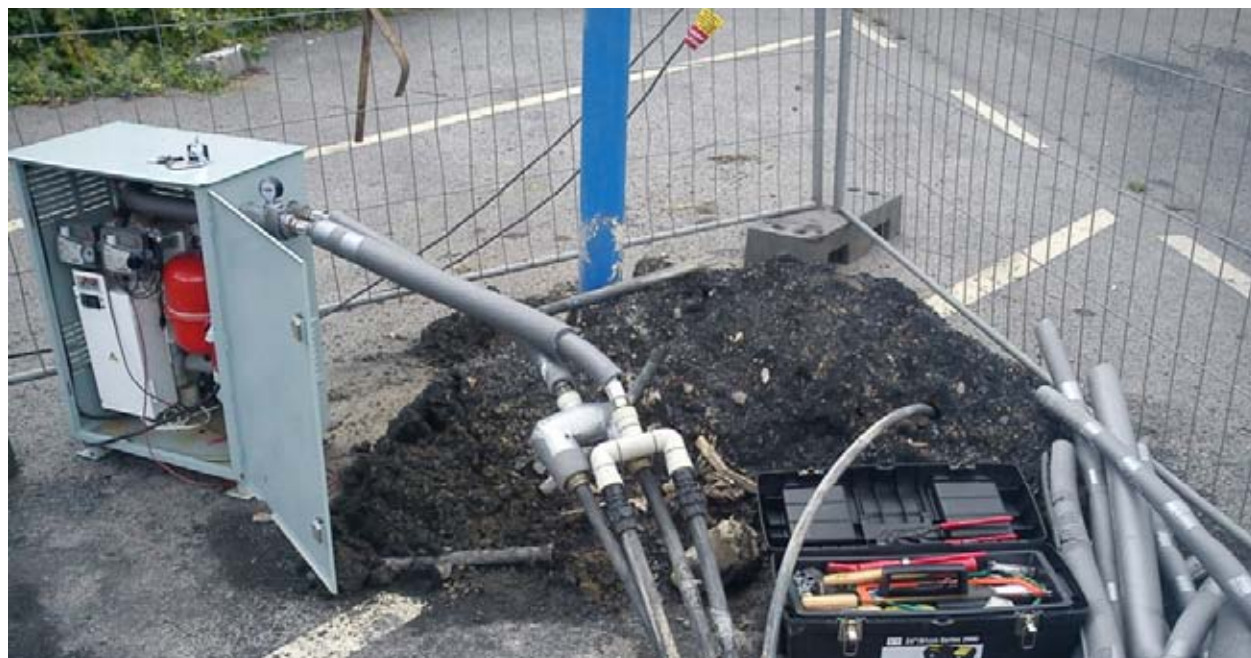
Měření tepelného odporu horninového prostředí pro verifikaci projektového řešení
