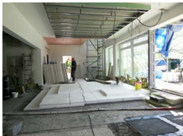
Izolace podlahy 1.NP
