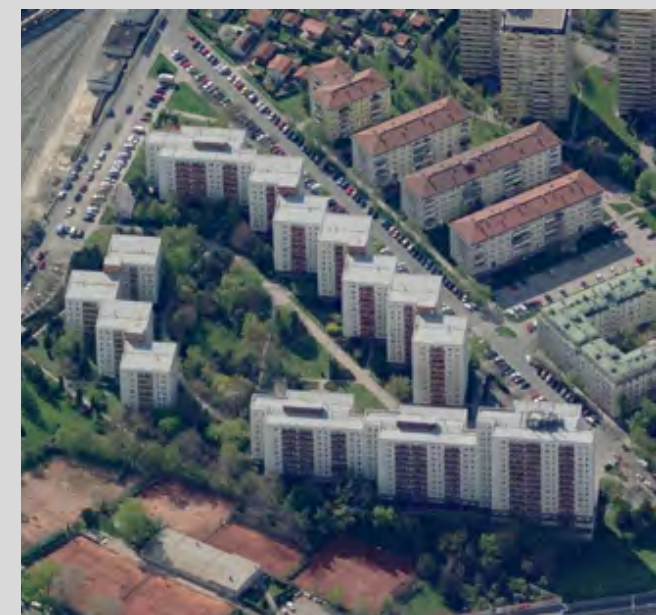
Původní stav sídliště na Hauffgasse před rekonstrukcí
