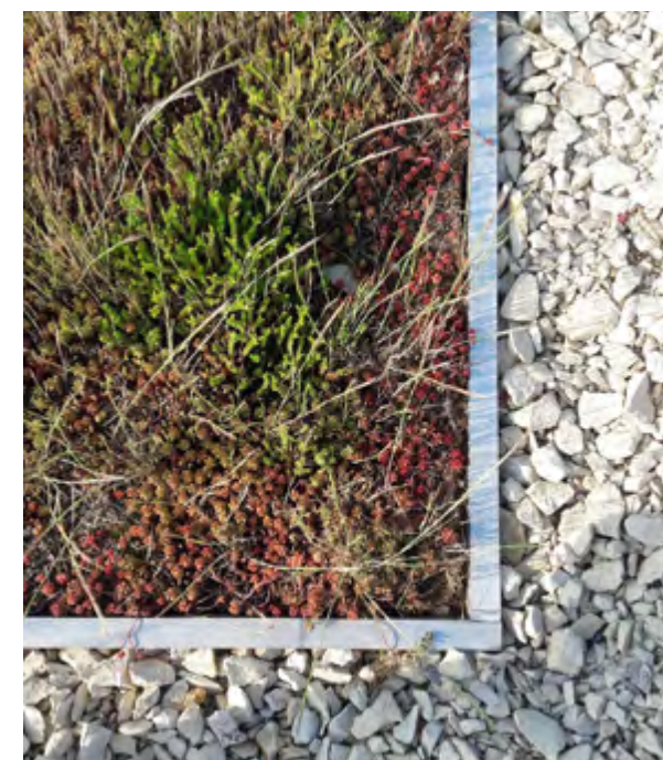
Detail obsypu vegetační vrstvy (Villa Sofia)
