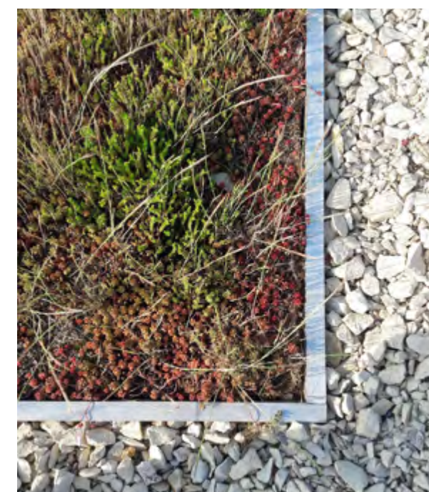
Detail obsypu vegetační vrstvy (Villa Sofia)
