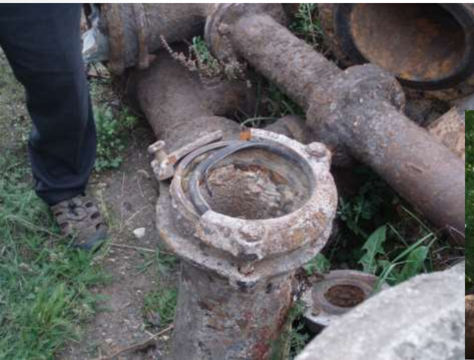
Gibaultova spojka a šoupata
