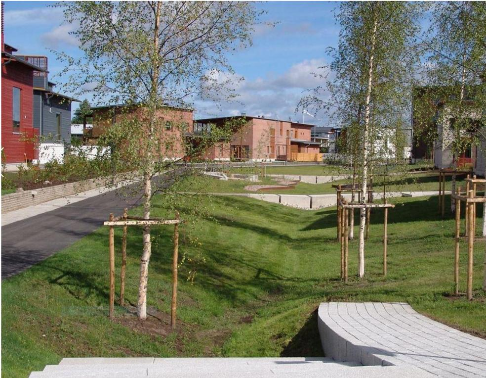
Abb. 5 Versickerungsmulde mit Kleindämmen
